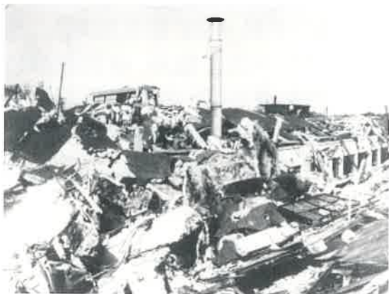
1923年 関東大震災で崩壊した三田工場
