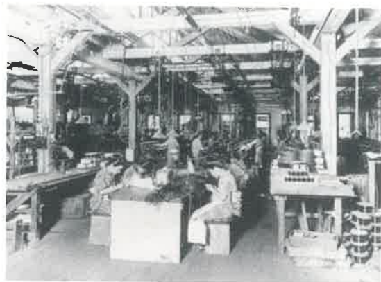
1920年頃 三田工場内の交換機用ケーブル製造風景
